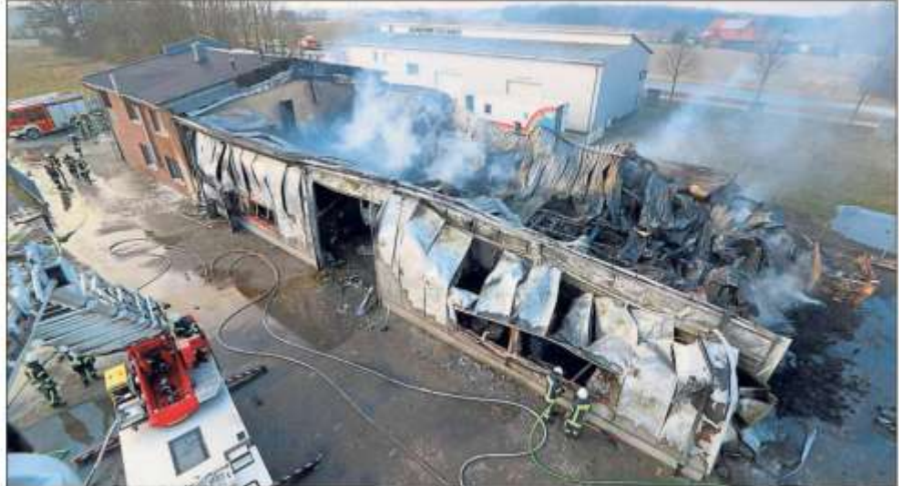
Komplett zerstört wurde bei einem Brand am Samstagmorgen eine Gewerbehalle an der Ludwig-Erhard-Straße in Stromberg. Die Löschzüge aus Stromberg, Oelde und Keitlinghausen-Sünninghausen waren mit 80 Kräften im Einsatz.
