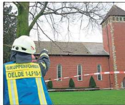
Weiträumig abgesperrt hat die Feuerwehr das Grundstück rund um die St.-Joseph-Kirche, nachdem der Sturm auch dort zahlreiche Ziegel vom Dach der Kirche abgedeckt hatte.
